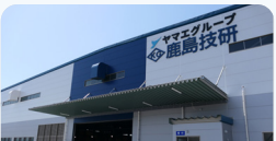
(株)鹿島技研 新本社工場
