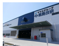
鹿島技研新本社工場
