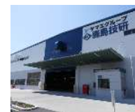
鹿島技研新本社工場
