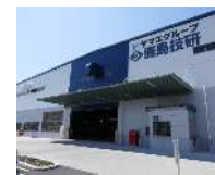
鹿島技研新本社工場
