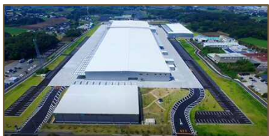
熊本物流センター稼働
