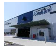
鹿島技研新本社工場
